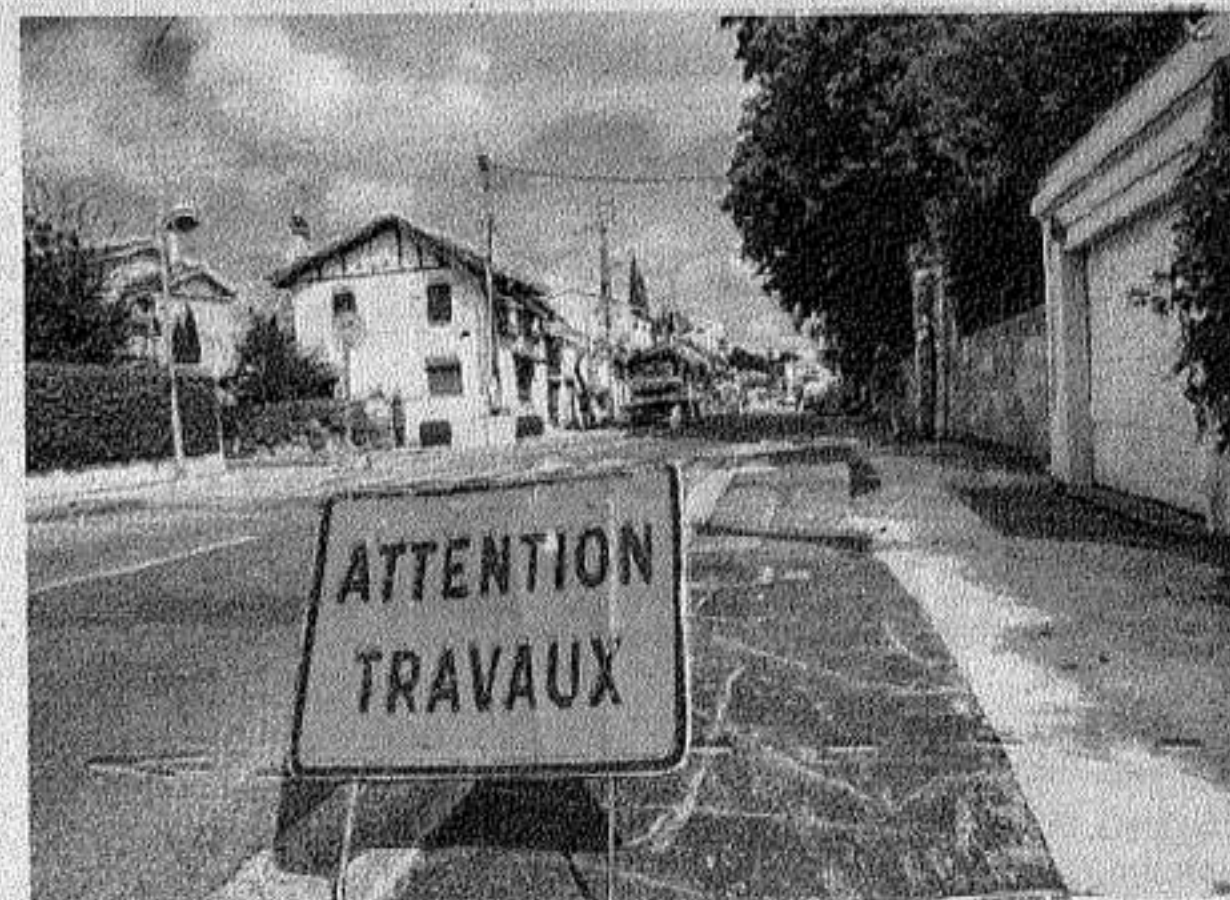
À l'issue des travaux du tram, il manquera des places de stationnement sur l'axe de la barrière du Médoc. PHOTO J.-M.L.B.
