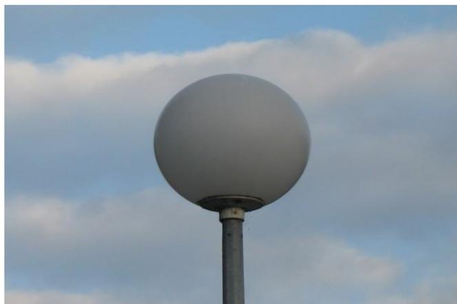
**Remplacement des luminaires équipés de sources SHP** (Sodium Haute Pression). Certains de ces appareils peuvent être, de part de leur ancienneté, en mauvais état car en fin de vie. Souvent de puissances élevées, leurs remplacements par des lanternes à leds permet de faire des économies d'énergies en baissant les consommations.
