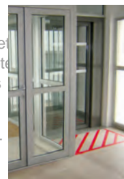
Mise en accessibilité du commissariat Installation d'un élévateur
